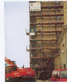
Sanierung des BMWi Bundesministeriums für Wirtschaft, Berlin (Sanierungskosten ca. 2,6 Mio. DM): Terminplanung und Bauleitung
