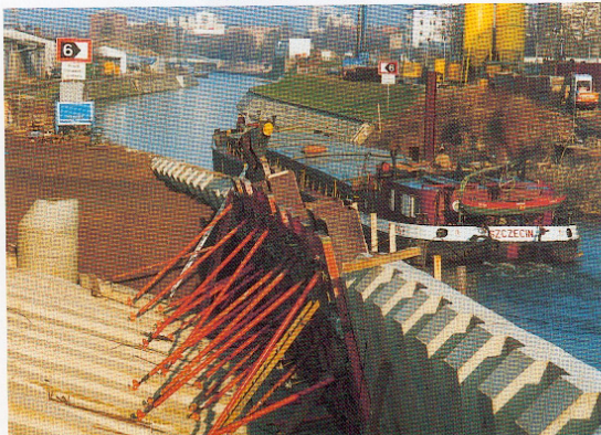
Spandauer Schifffahrtskanal, Berlin, Uferbefestigung Neubau und Sanierung (Gesamtkosten 21 Mio. DM): Terminplanung, Bauleitung, Nachtragsmanagement Wasser- und Spezialtiefbau
